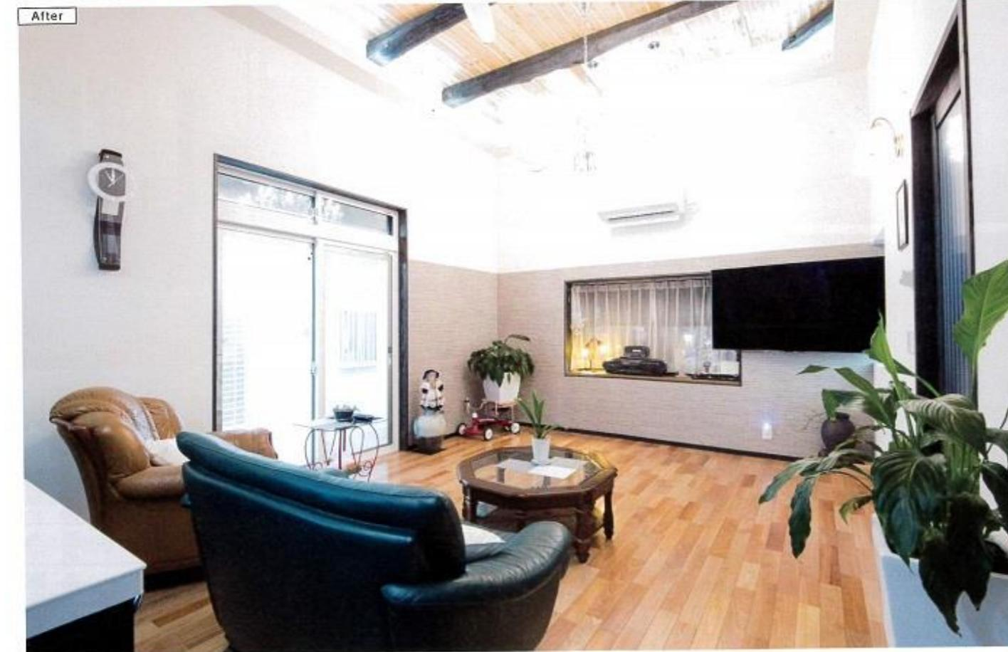
LDKは、天井に新たに加えた補強梁が元からあった古い梁とサイズ、色、質感がそっくりの仕上げに。薪ストーブの設置に備え、床の一角には床暖房を入れず、煙突工事の際は天井の
